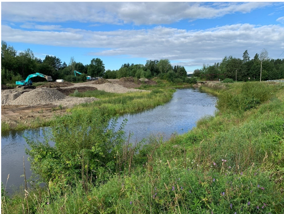
Foto 18. Püssi kalapääsu rajamise tööd (12.08.2024).
