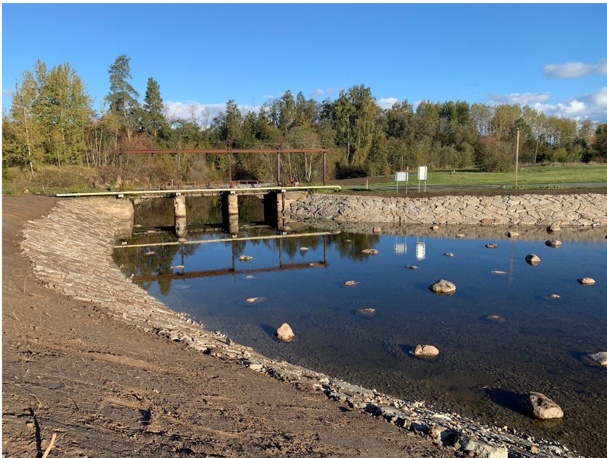
Foto 20. Püssi kärestik-kalapääsu allavoolu jääv osa pärast ehitustööde lõpetamist (30.09.2024).
