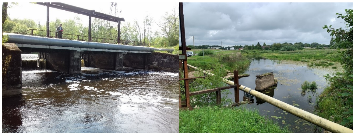
Foto 16. Püssi pais (vasakul; 21.05.2019) ja foto 17 Püssi paisust ülesvoolu jääv jõesäng (tulevase kalapääsu asukoht) enne kalapääsu rajamise ehitustööde algust (30.07.2024).
