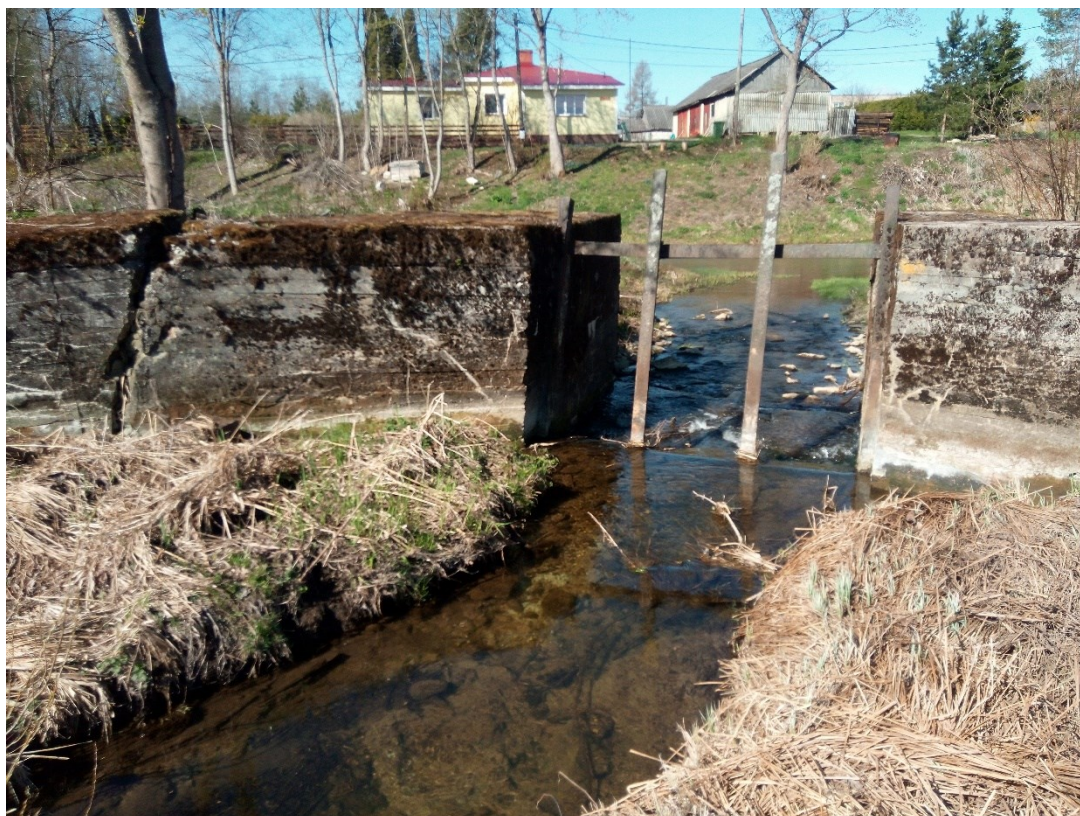
Foto 26. Varja oja pais vaatega allavoolu. Puidust varjad on eemaldatud, betoonist künnis on veel alles (09.05.2022).
