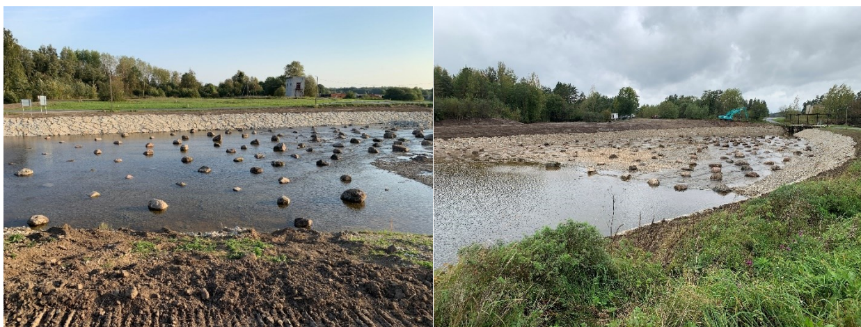
Foto 19. Püssi kalapääsu rajamise tööd: paekivist kaldakindlustuste ehitamine ja voolurahustuskivide paigaldamine (10.09.2024 ja 27.09.2024).
