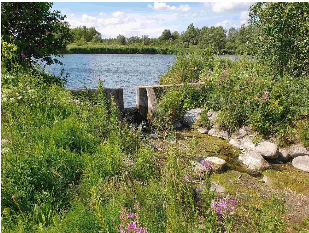
Foto 11. Sõmeru jõgi, Rägavere kalatee sissevool, 4.07.2023. Selline varjadega betoonkonstruktsioon on ülesvoolu rändel kaladele ületamatu ja võimaldab omavolilist veetasemetega manipuleerimist.
