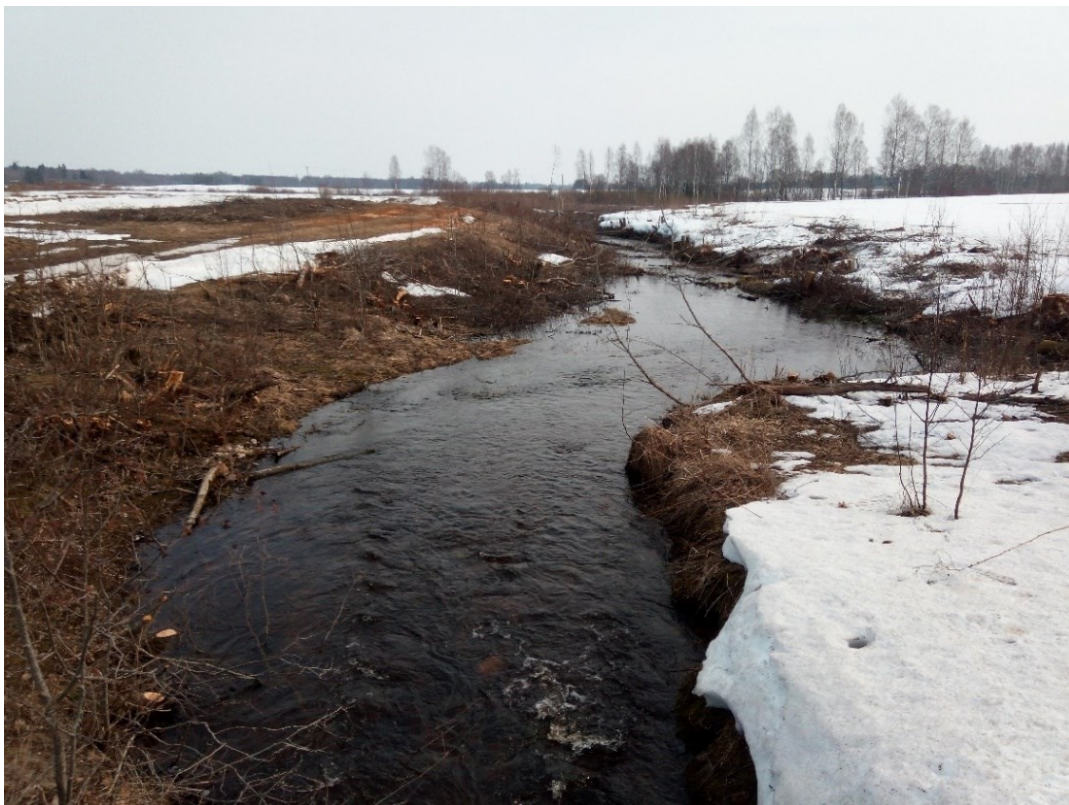
Foto 8. Pakitu peakraav peale kallaste puhastamist kraavide hoolduse käigus.
