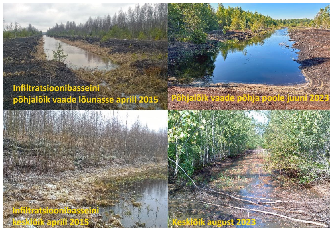
Foto 2. Infiltratsioonibasseini põhja- ja kesklõik aprillis 2015 ja 2023 aasta suvel.
