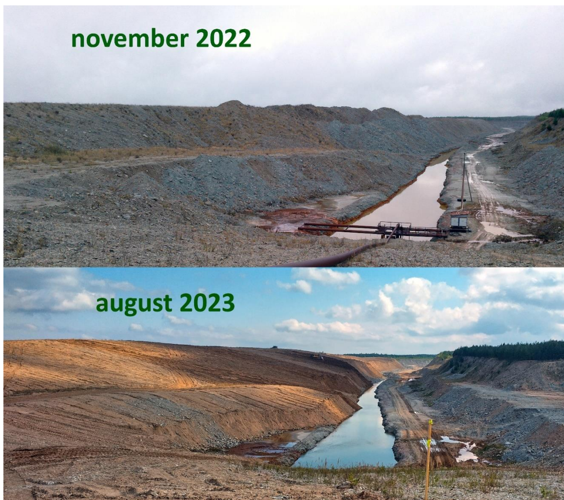
Foto 1. Infiltratsioonibasseini pumbajaam nr 2 juures lõputranšee nõlvade laugendamine.
