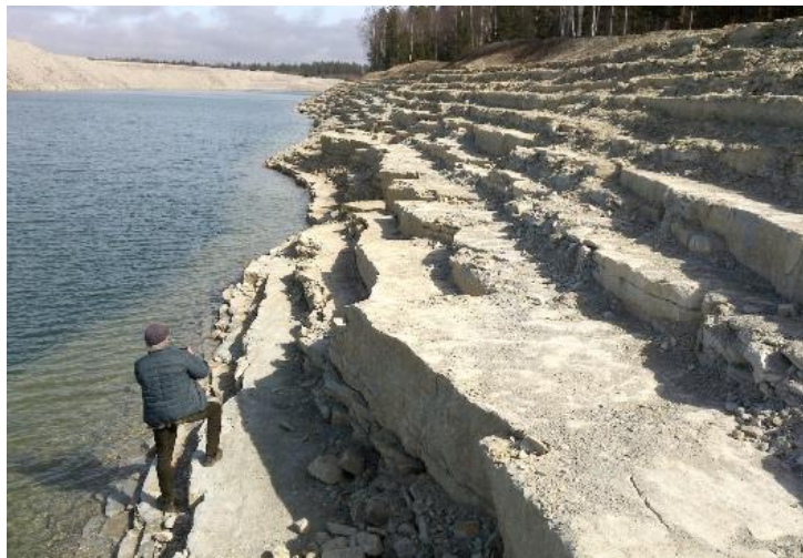
Foto 2. Aidu lõunapoolse lõputranšee veepiirist kõrgemale olev kaldanõlv on inimeste ohutuse tagamiseks laugen- datud astmeliselt (aprill 2021).
