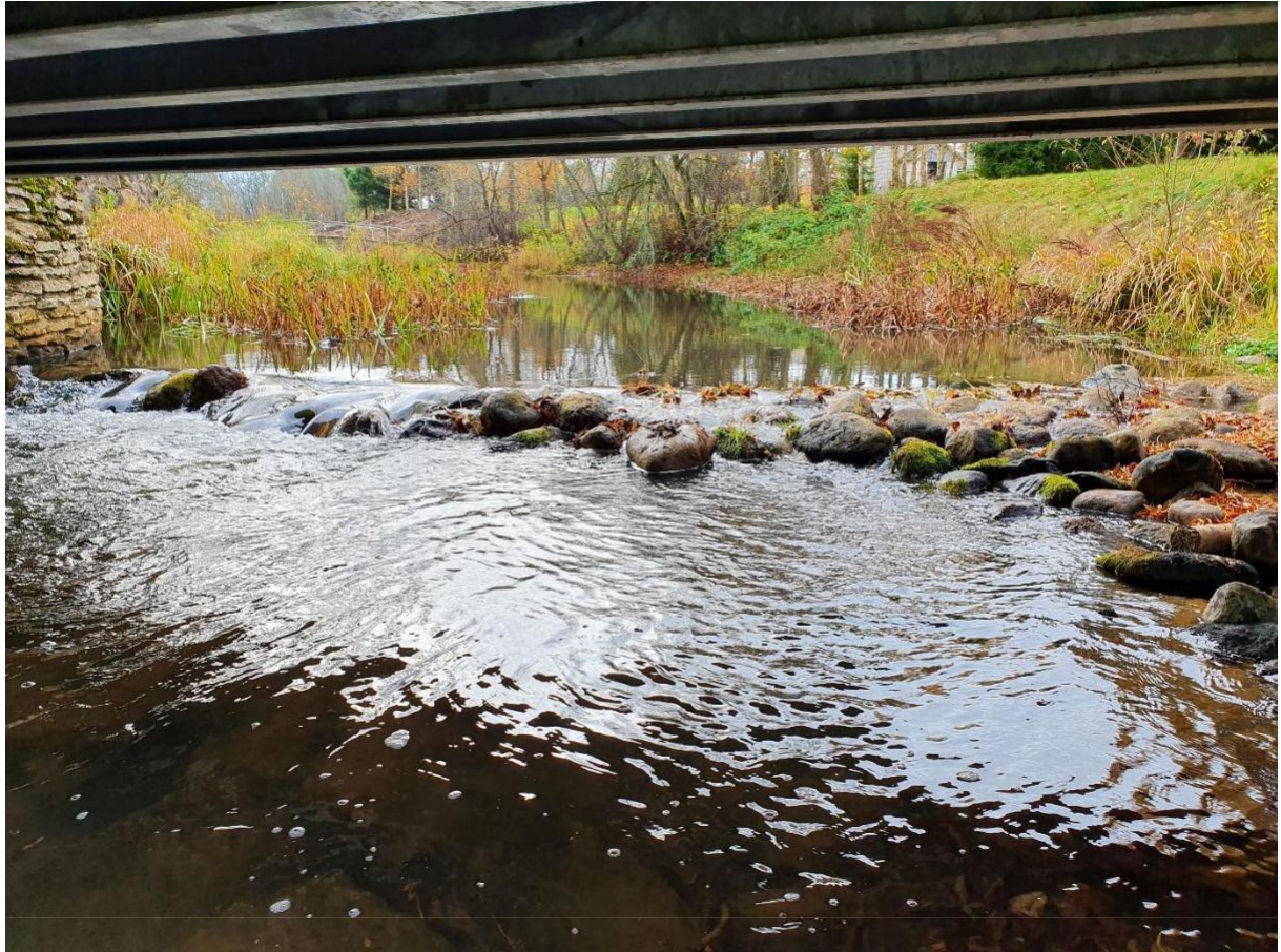
Foto 13.10.2021. Koila kärestikulise kalapääsu sissevoolule on tekkinud kivivall.
