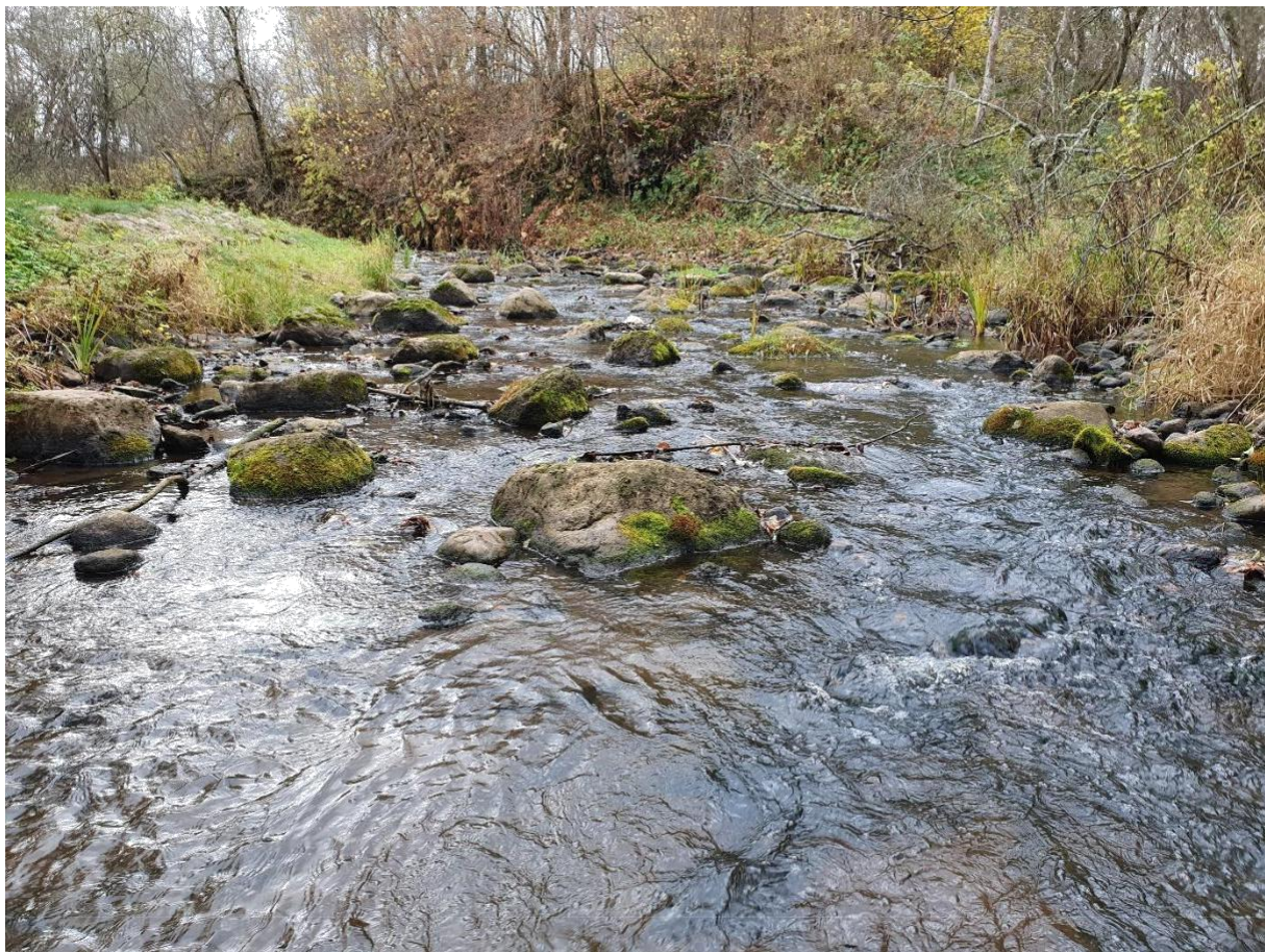
Foto 13.10.2021. Adrika tehiskärestikuline kalapääs oli vaatluste ajal heas korras ja kaladele mõlemasuunaliselt läbitav.
