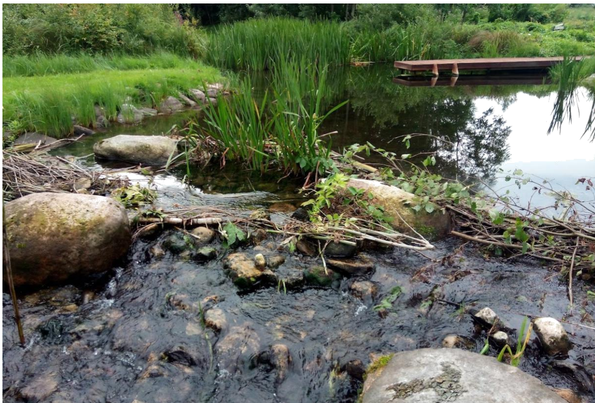
Foto 17.08.2021. Neeruti kalapääsu sissevoolu võiks perioodiliselt risust puhastada.
