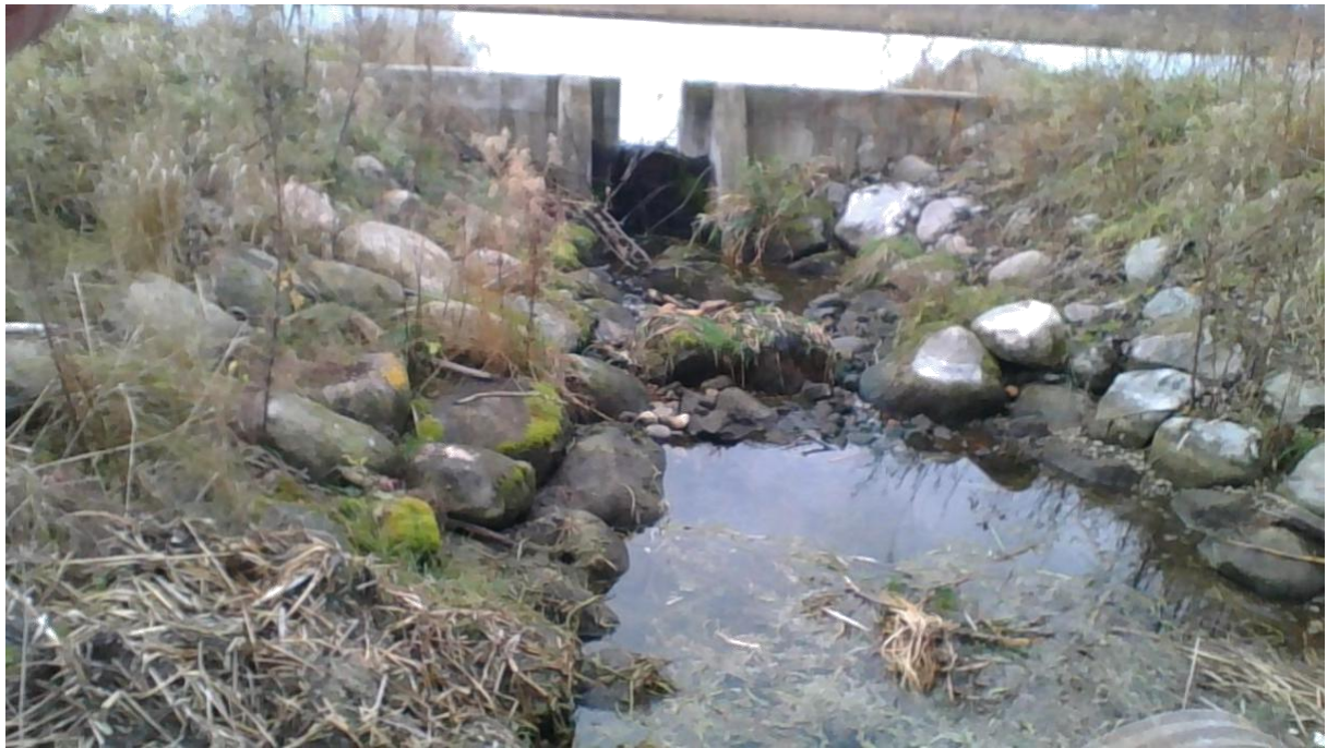
Foto 04.11.2021. Rägavere kalapääsu sissevool on suletud laudadega, paisutuse kõrgus on 67 cm.
