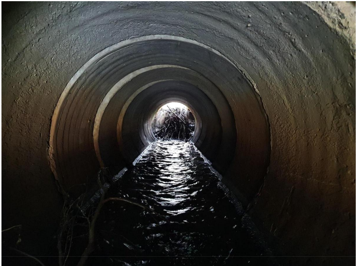
Foto 13.10.2021. Truubi teine haru. Kobras on ka selle sissevoolu blokeerinud.
