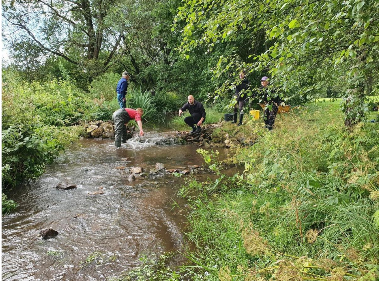
Foto: 04.08.2021. Jõekääru paisu lammutamine Udriku ojal.
