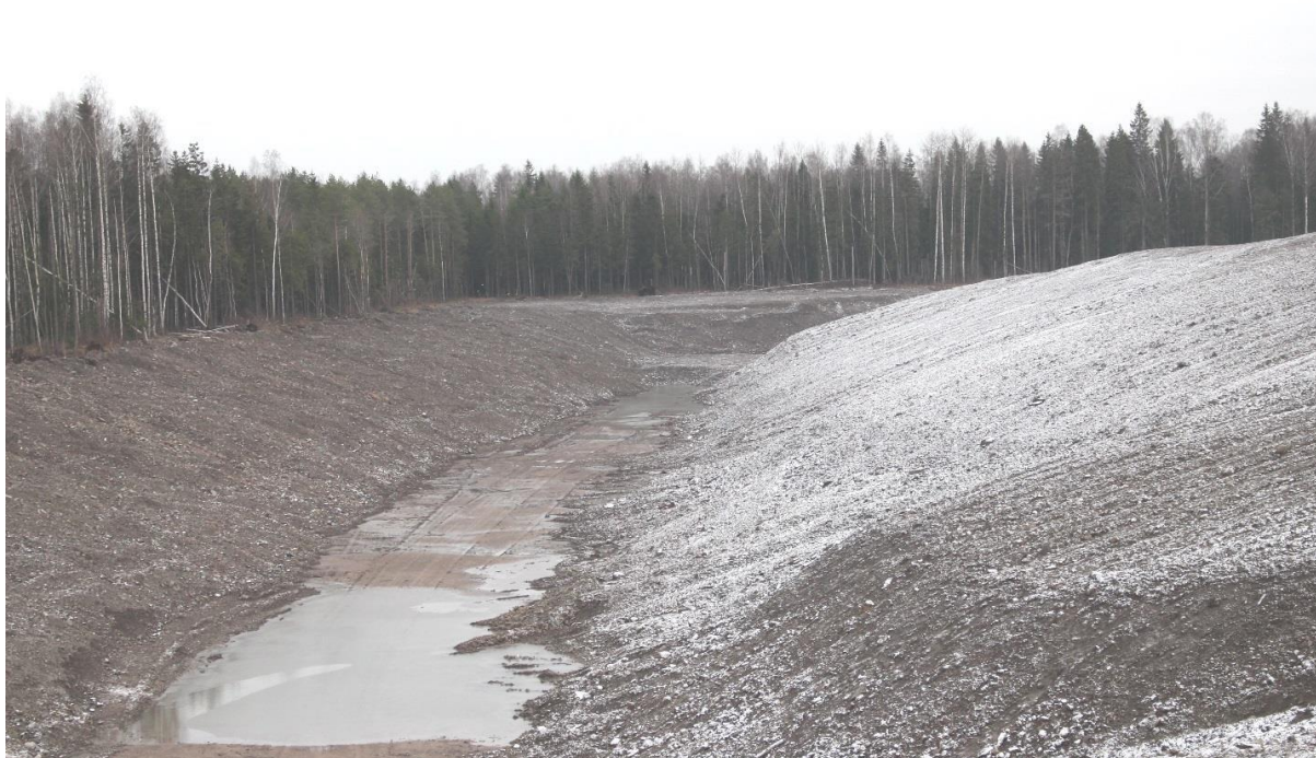
Foto 1 Tranšee nr 13 viimane kaevandatud kaevesamm idaosas pärast korrastamistööd (Melnik, jt., 2016).
