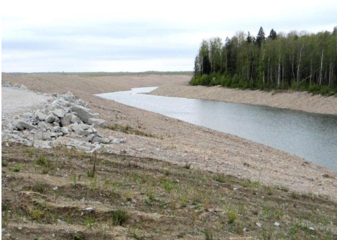
Foto 2 Tranšee 13 kirdeservas on veekogude kaldad muudetud laugeiks. See soodustab kallaste kiiremat taimestumist, selle toetamiseks võiks sinna istutada ka põõsaid või puid (foto J.Paal)
