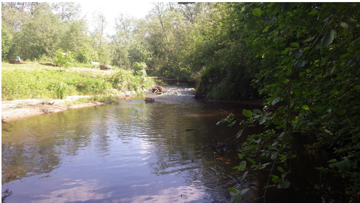
Foto 06.06.2019. Unukse veski paisuvare juures probleeme ei täheldatud. Vaade vastuvoolu.
