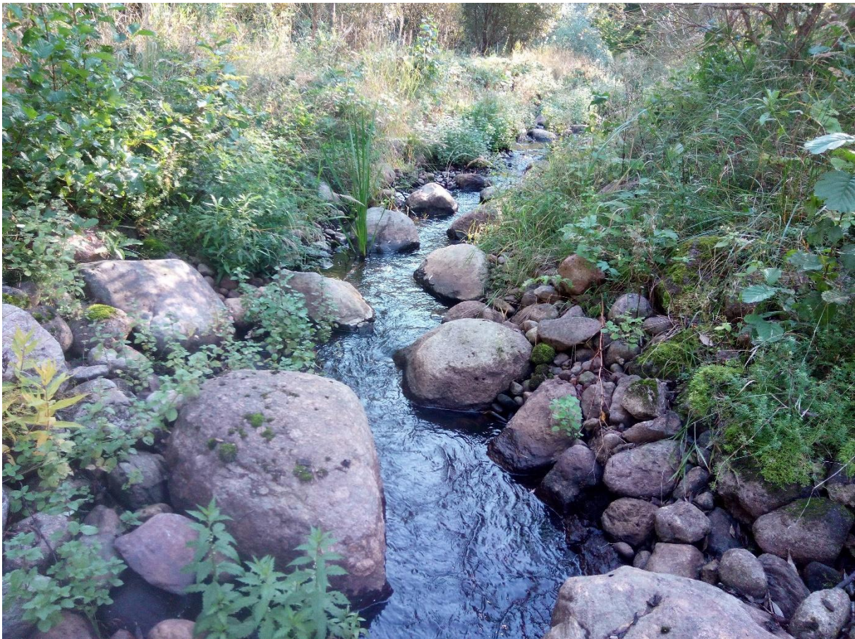
Foto 10.09.2021. Pajuveski kalapääs on loodusliku ilmega, olles seepärast kaladele atraktiivne ka jõe väikeste vooluhulkade korral.
