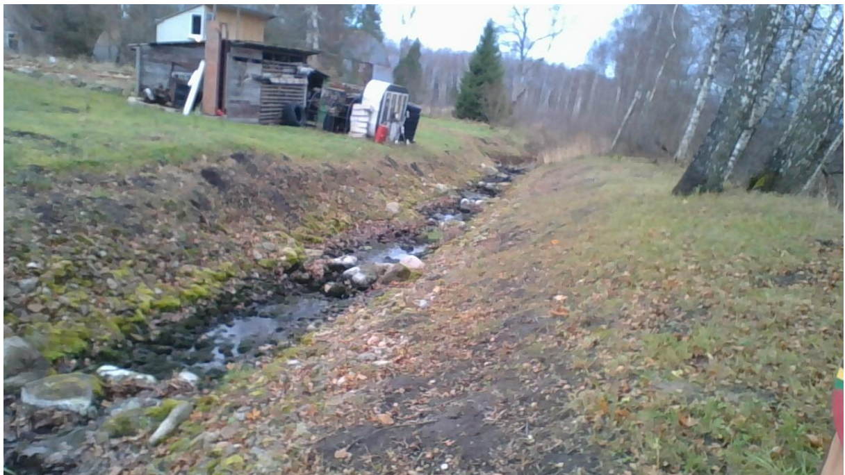
Foto 04.11.2021. Veevoolu katkestamisel tekivad kalapääsule väikesed veesilmad, kust kaladel on lahkumine raskendatud või võimatu. Kalapääs on elupaigaks forelli noorjärkele, lisaks mitmetele teistele liikidele.
