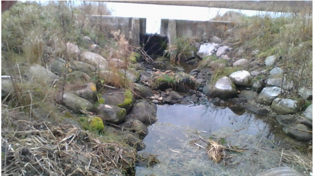
Foto 04.11.2021. Rägavere kalapääsu sissevool on suletud laudadega, paisutuse kõrgus on 67 cm.
