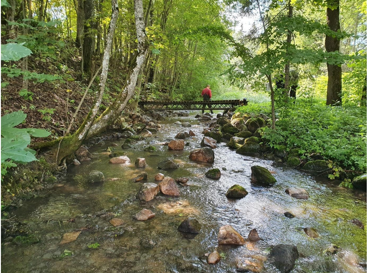
Foto: 04.08.2021. Udriku 2 pais pärast lammutamist, paisukehaks olnud kivid on ojja hajutatud.
