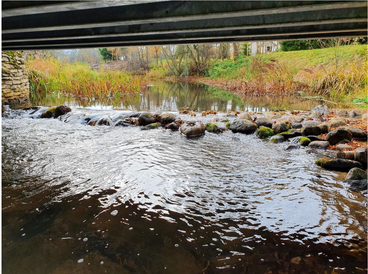
Foto 13.10.2021. Koila kärestikulise kalapääsu sissevoolule on tekkinud kivivall.
