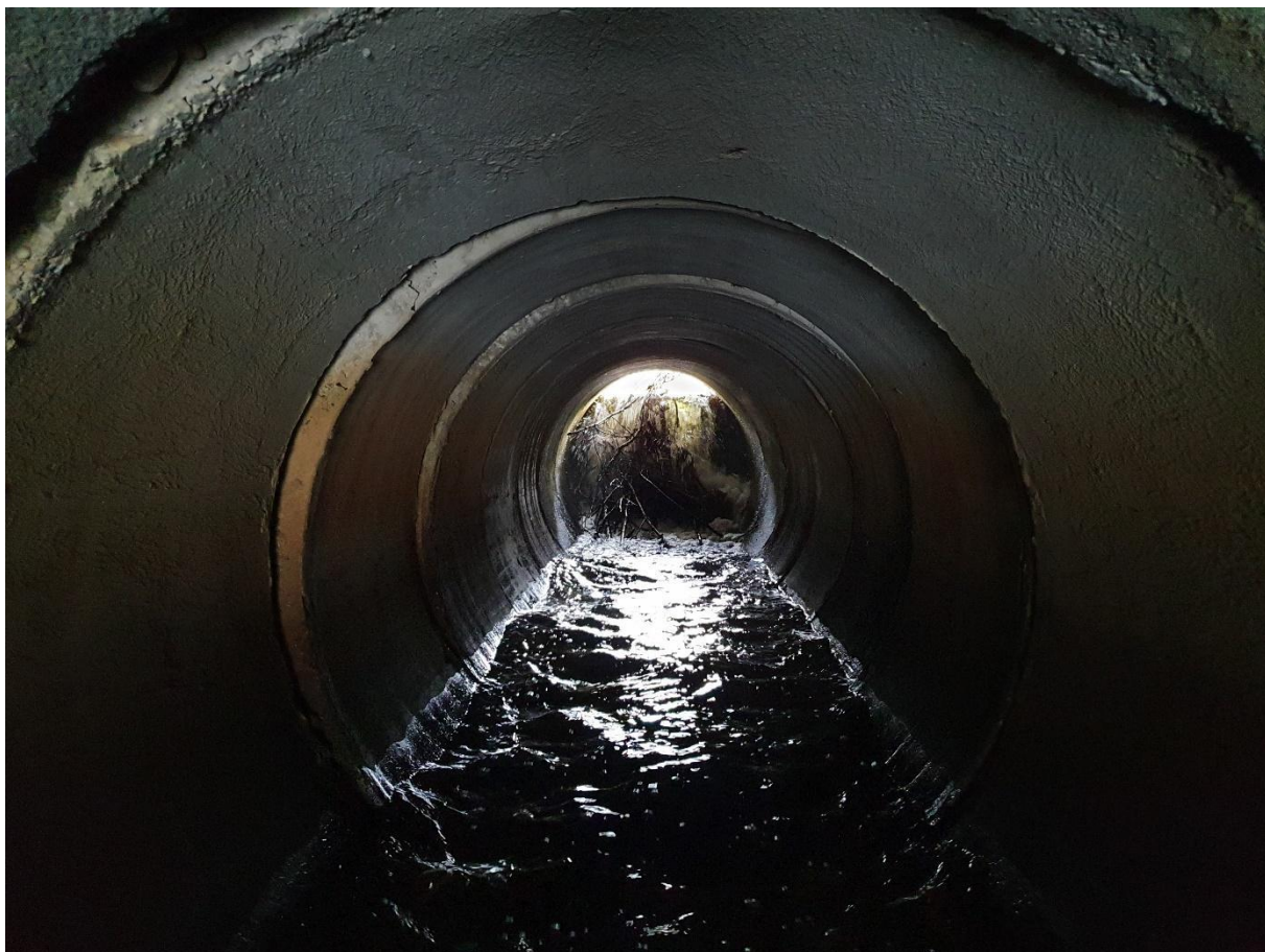
Foto 13.10.2021. Kobras on Unukse teetruubi sissevoolu blokeerinud.
