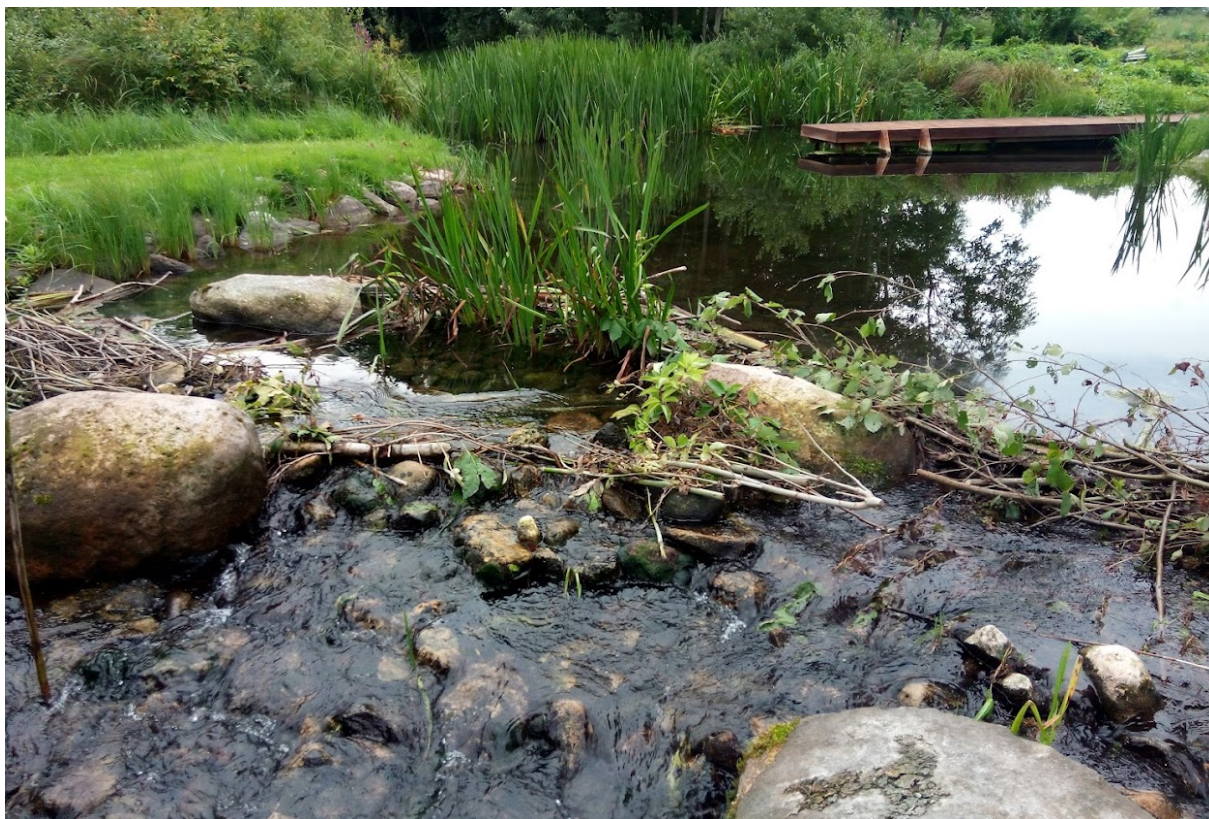
Foto 17.08.2021. Neeruti kalapääsu sissevoolu võiks perioodiliselt risust puhastada.
