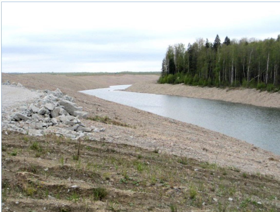
Foto 3. Rästikmetsa järve idaosas on veekogude kaldad muudetud laugeiks. See soodustab kollaste kiiremat taimestumist, selle toetamiseks võiks sinna istutada ka põõsaid või puid (foto J.Paal)[2].
