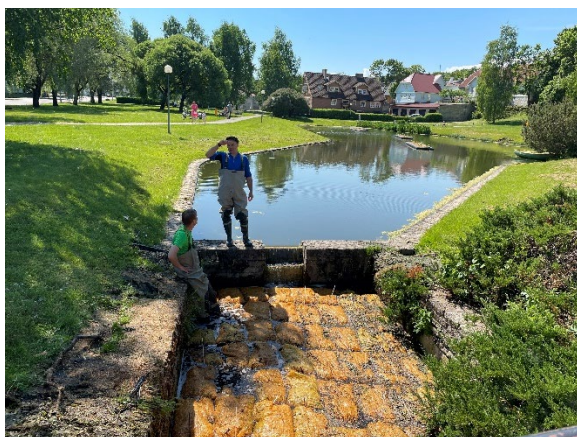
Foto 11. Puiduhakke filtri paigaldamine Kirikuaia parki
