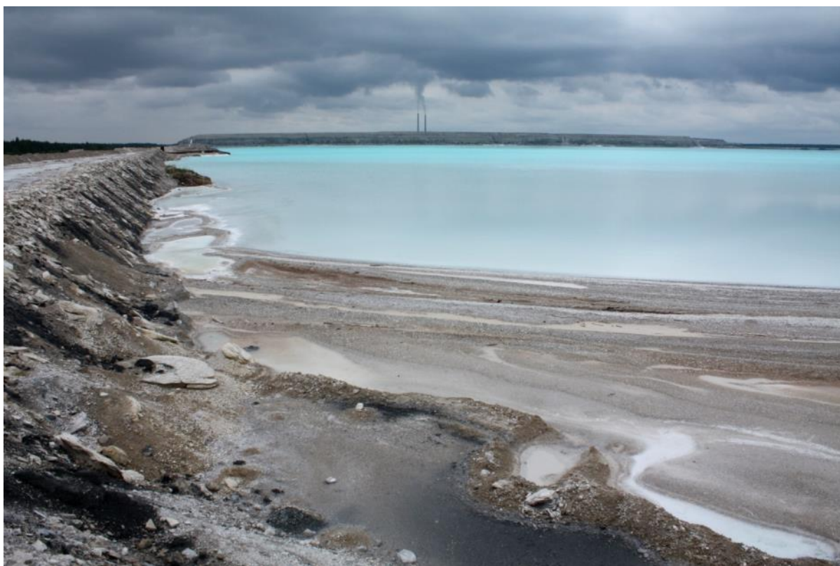
Foto 4. Põlevkivituha settebassein Eesti soojuselektrijaama lähistel.
