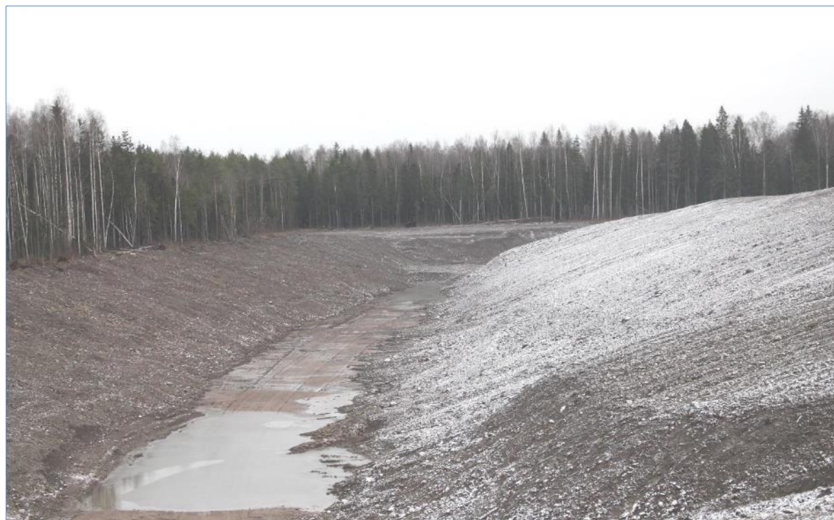
Foto 14. Tranšee nr 13 viimane kaevandatud kaevesamm idaosas pärast korrastamistöid (foto Melnik, jt., 2016).
