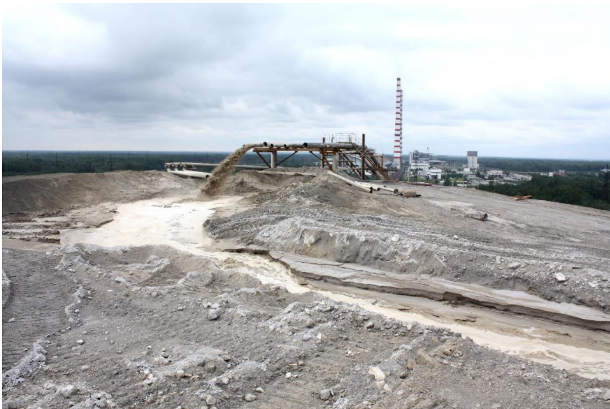
Foto 3. Põlevkivituha hüdrotransport Eesti soojuselektrijaama kateldest ladestusalale.
