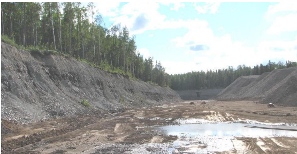
Foto 10. Tranšee nr 13 viimane kaevandatud kaevesamm idaosas enne korrastamistöid (foto Melnik, jt., 2016).
